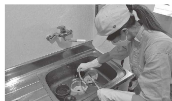
配管洗浄作業の様子
